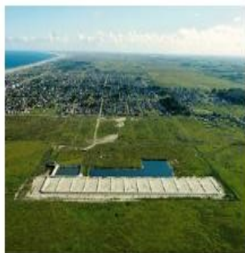
Bacias de Infiltração
