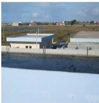
Filtro Aerado Submerso
