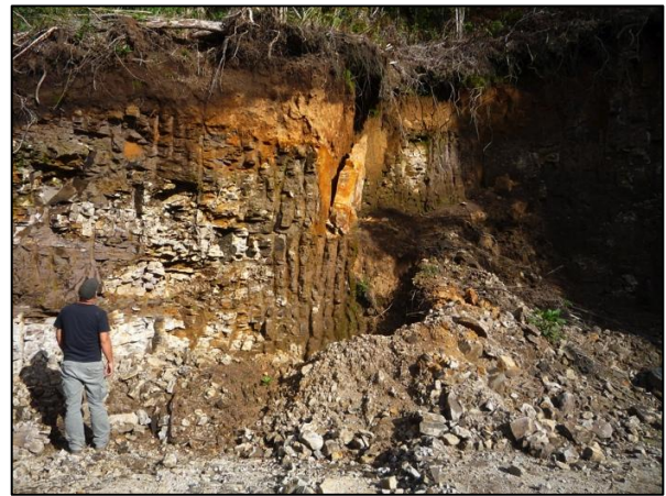
Foto 45: Saibreira à margem da via, com de 6 metros de altura, ao longo dos quais verifica-se os diferentes graus de alteração da rocha.
