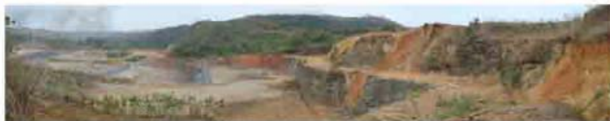
Foto 57: Vista geral da cava 3, em operação.
