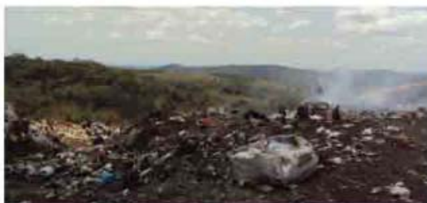
Foto 63: Lixão de Matozinhos, instalado próxima área da indústria Belocal.
