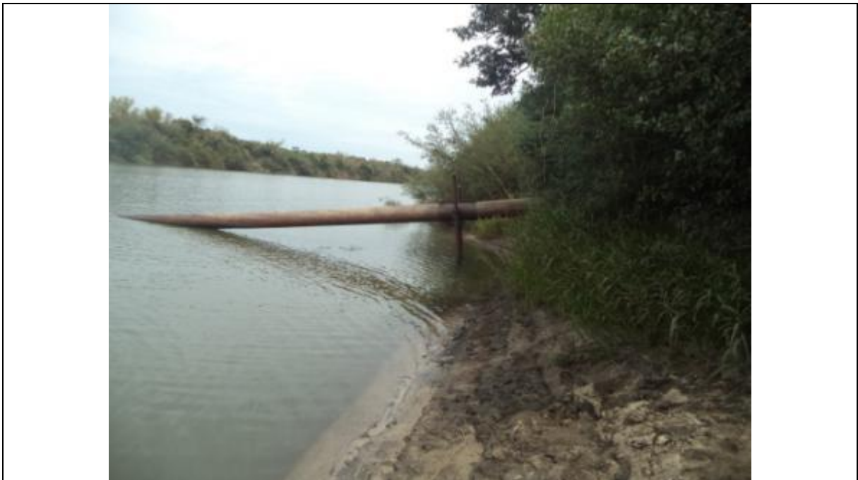
Figura 6.2-79 Adutora de captação de água para irrigação da cultura do arroz.
