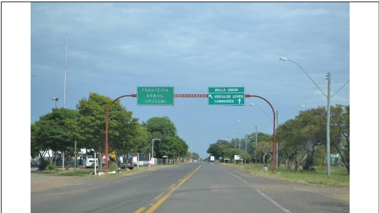
Figura 6.4-12 Acesso para ponte de ligação entre o Brasil e Uruguai em Barra do Quaraí.
