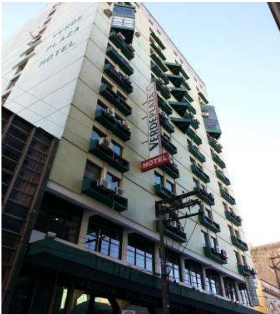
Figura 68: fachada do Hotel Verde Plaza
