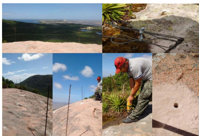
Figura 3: Fixação da contenção na Pedra da Visão.
