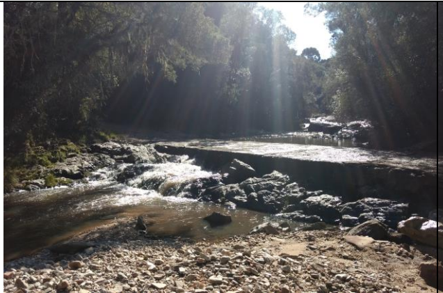
1 ponte de concreto sobre o Arroio dos Lopes
